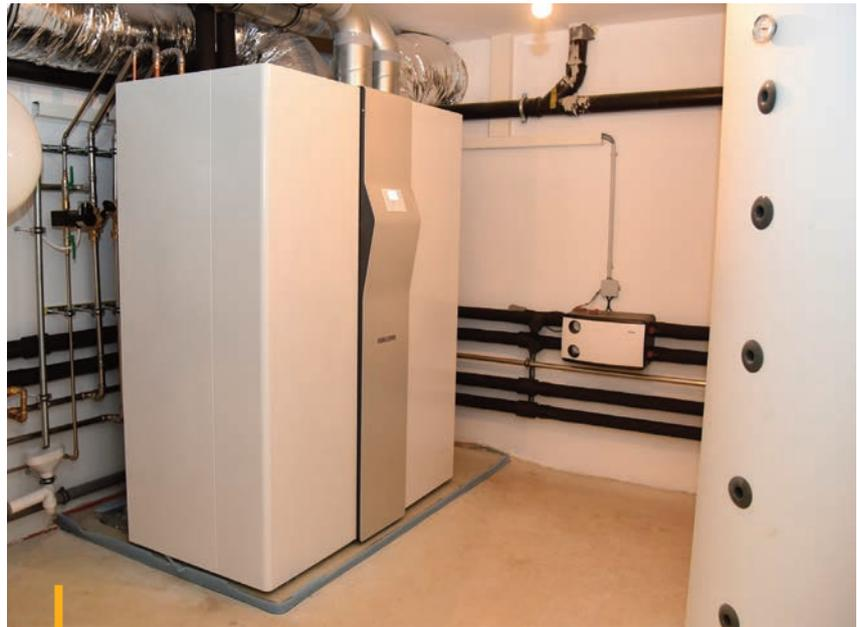
Die LWZ 504 übernimmt in jedem Gebäude die Ent- und Belüftung, Beheizung, Warmwasserbereitung und auf Wunsch auch Kühlung.
