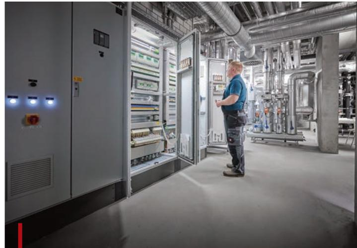
Innerhalb des GAZ gibt es fünf Gruppen von Verteilerschränken, in denen elektrische Geräte und Steuerungen installiert sind, darunter 95 Cylon-Controller.
