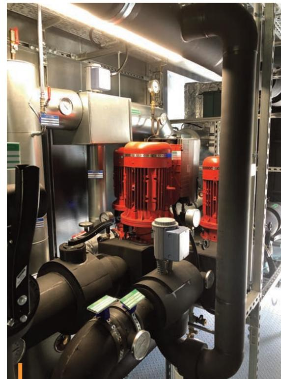
Insgesamt vier Pumpen werden benötigt, um das Gebäude über den Container zu kühlen.
