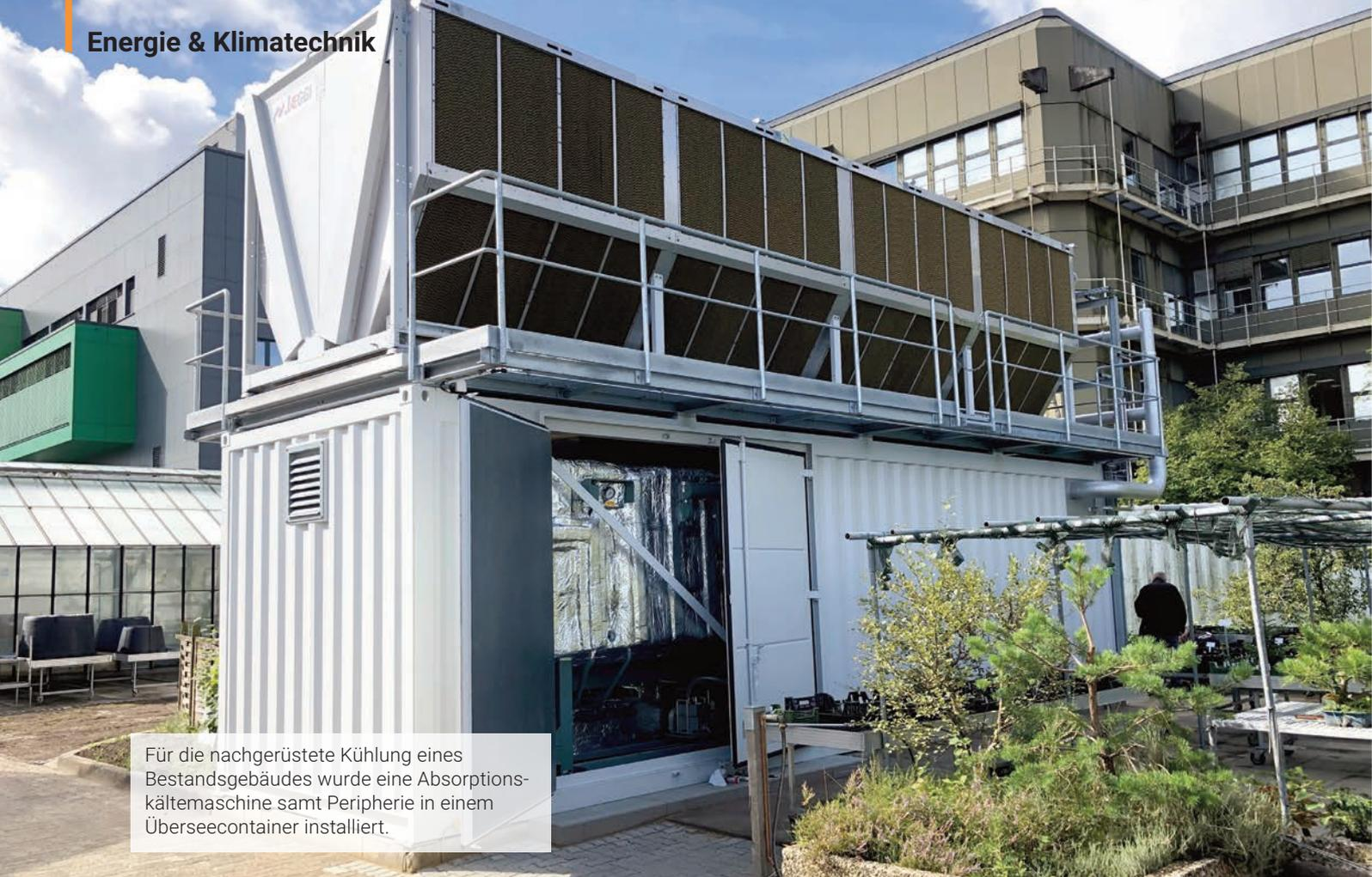
Für die nachgerüstete Kühlung eines Bestandsgebäudes wurde eine Absorptionskältemaschine samt Peripherie in einem Überseecontainer installiert.
